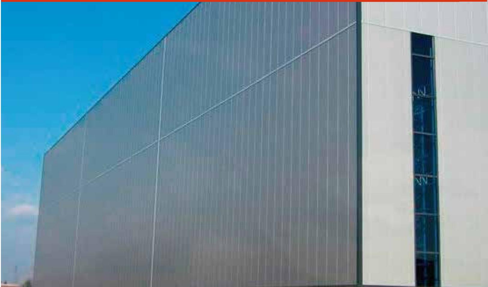
ISOBOX es un panel metálico auto portante micronervado en ambos lados, aislado con poliuretano destinado a la realización de paredes y fachadas de edificios industriales y prefabricados en obra, cámaras de secado y a compartimientos en general. Gracias a la sección simétrica y a las clásicas superficies perfiladas, ISOBOX asegura buenos resultados estéticos.
